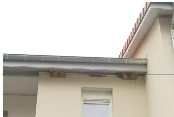
Maizières-lès-Metz : deux nichoirs artificiels installés en remplacement des nids détruits lors des travaux. La colonie peut se réinstaller. Crédit : LPO
